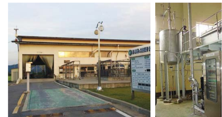
〈보령시 축산폐수 공공처리시설〉
